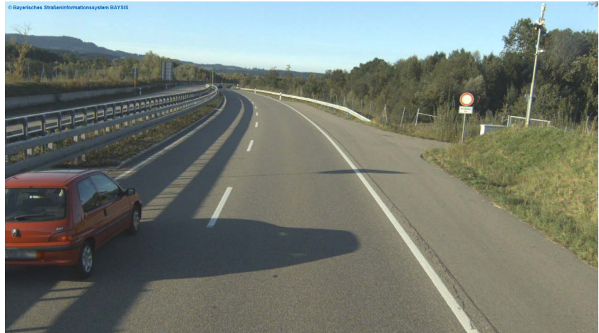
» Abb. 14 Streckenfoto von der Bundesstraße B 19 aus dem Jahr 2019 im Bereich der SWS „Stein-Iller“
